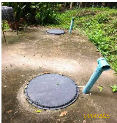
รูปที่ 2-33 ระบบบำบัดน้ำเสียแบบถังเกรอะกรองไร้อากาศ
