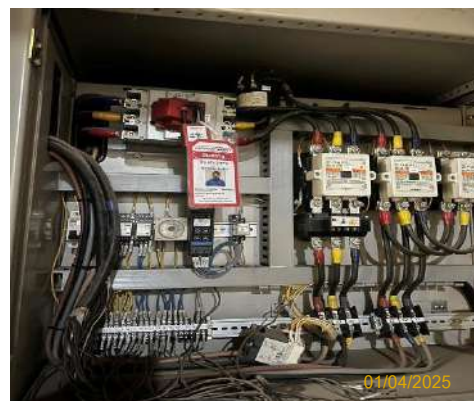
รูปที่ 2-64 ใส่กุญแจจาวลั้ว สวิตช์และติดป้ายแจ้ง (Lock out-Tag out)
